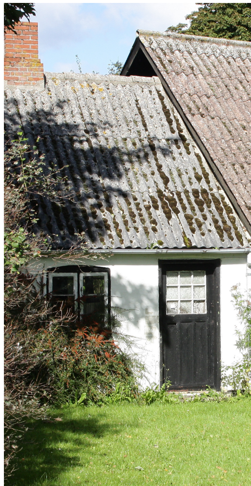
Døre og vinduer er traditionelt udført med sprosser
