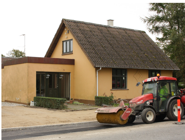
Tilbygningen har fået samme overflade og farve som huset
