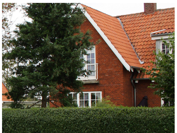
Hus med hvide vinduesrammer og altan med stålgeleander
