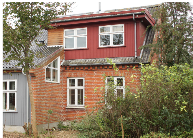
Kvisten på boligen her ændrer den oprindelige bygnings udtryk
