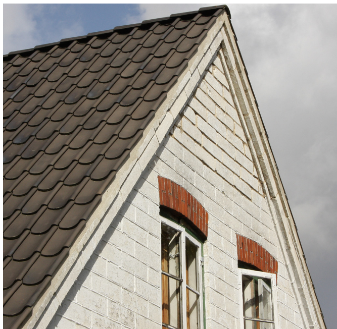
Kridtstenshuse med stik over vinduerne udført i henholdsvis røde og gule tegl.
