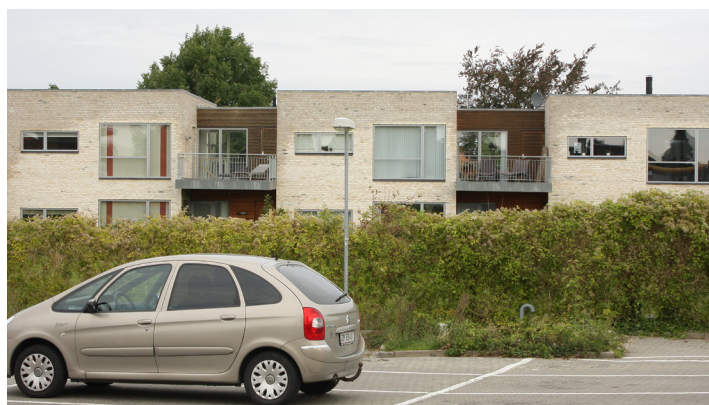
Rækkehusene ved centerområdet
