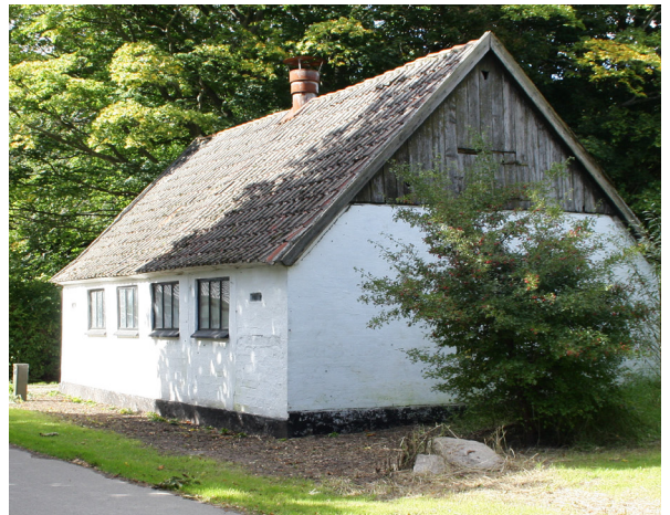
Landhus som fritliggende længehus i kridtsten
