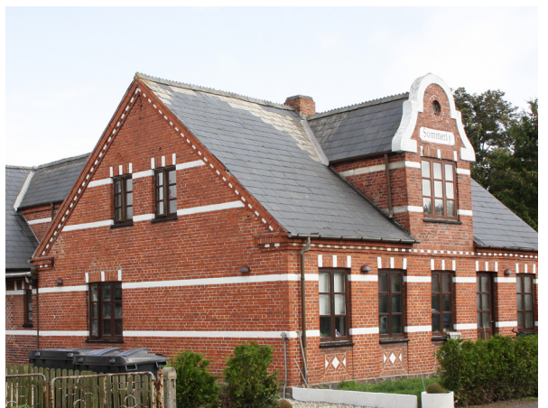
Rig facadeudsmykning på blank mur
