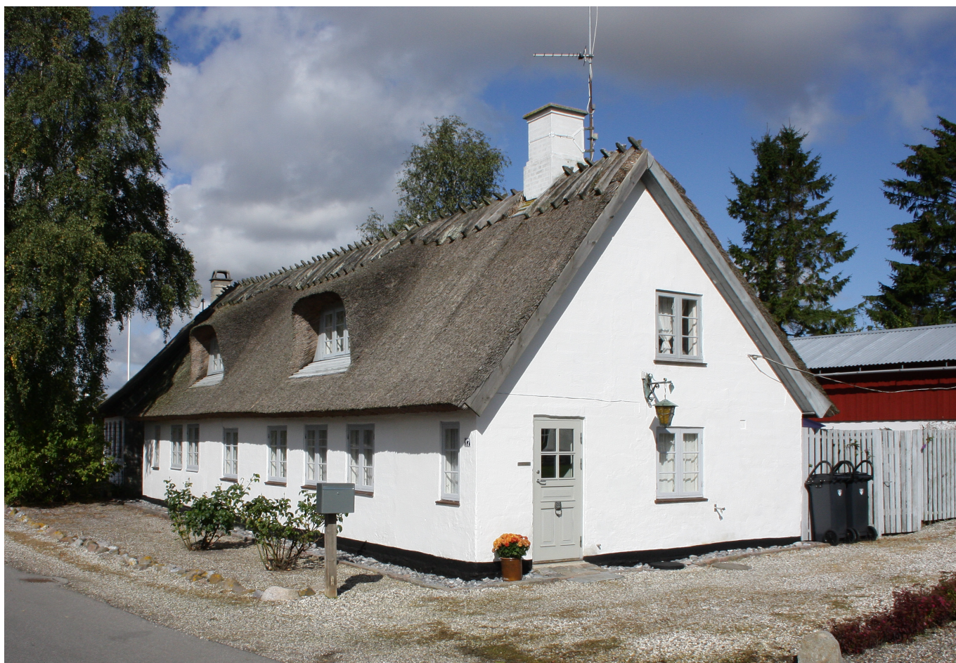
Istandsatt længehus med stråtag. Skorsten, kviste og kragetræer er bevaret, hvilket er med til at fastholde husets originale udtryk
