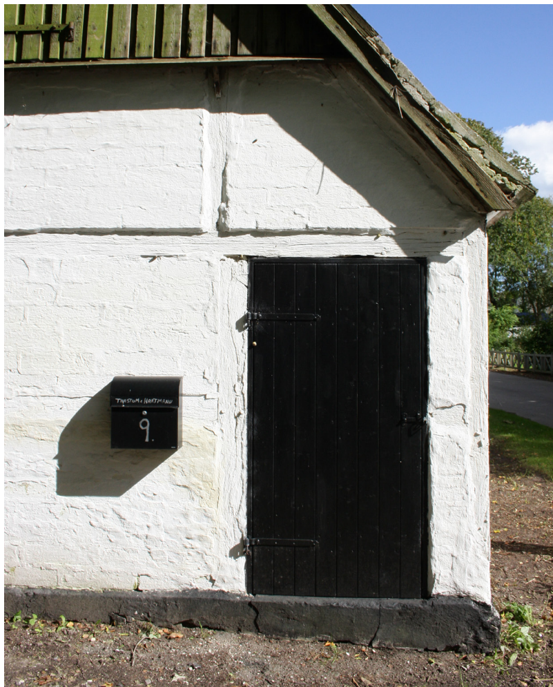
Det overkalkede bindingsværk er en sydsjællandsk byggeskik
